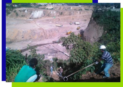
La red de conducción de Biogás es por medio de tubería de Polietileno de alta densidad (PEAD) de 90 mm de diámetro.
