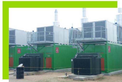
La capacidad instalada para la generación de energía eléctrica por medio del biogás en el Sitio de Disposición Final (SDF) es de **4MW**
